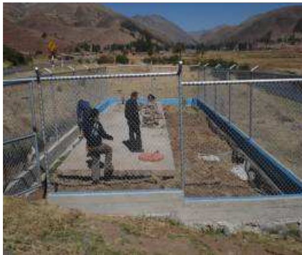
Captación Hercca no cuenta con rotulo de identificación.
